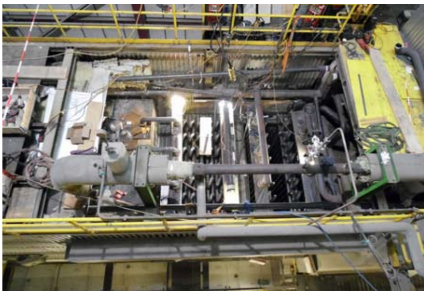
Blick in die geöffnete Kesseldecke der OL 3
