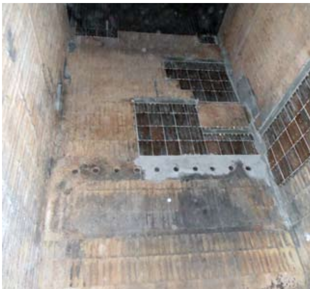
Reparaturen am Mauerwerk der OL 3
