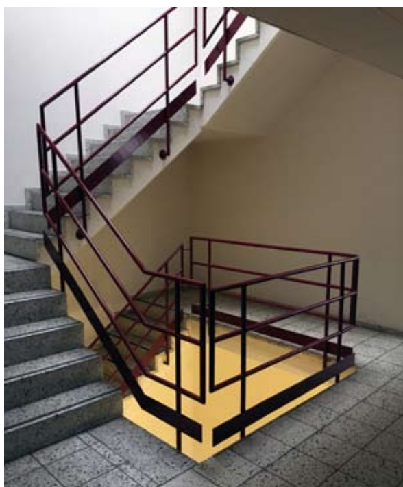
Treppengeländer wurde erhöht
