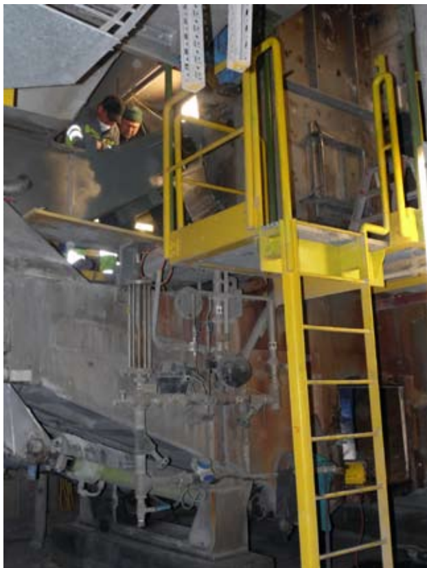
Sanierungsarbeiten am Trogkettenförderer der OL 4
