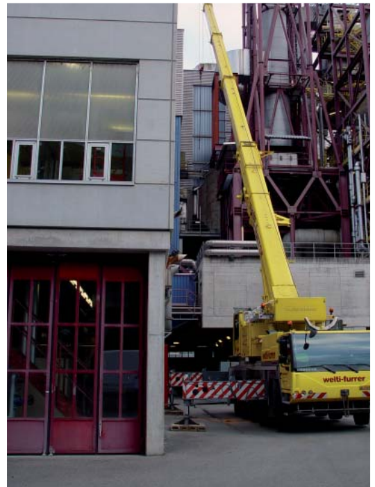
Montage des Rauchgaswäscher-Bypasskanals
