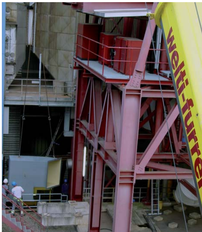
Montage des Rauchgaswäscher-Bypass-Kanals
