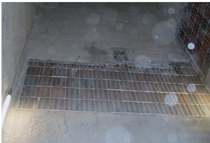
Reparierte Ausmauerung im Feuerraum der Ofenlinie 3
