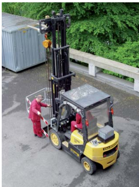
Ausbau einer Kühlwasserpumpe
