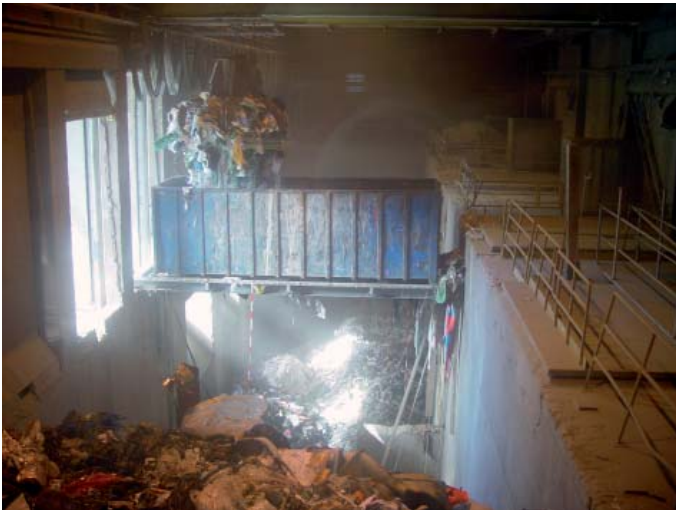
Müllabtransport während der Gesamtabstellung
