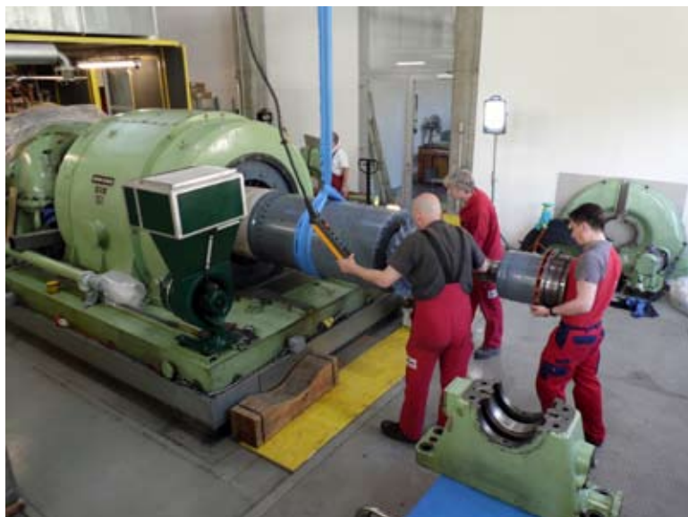
Der revidierte Generatorrotor wird wieder eingebaut
