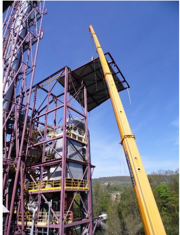
Montage des Dachs über den Rauchgaswäschern
