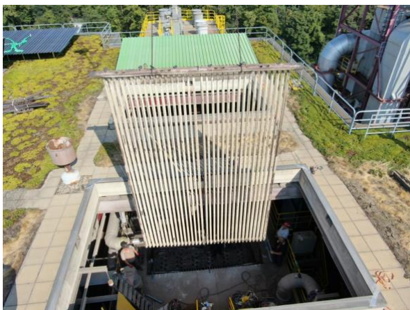
Neue Überhitzerbündel werden in den Kessel der OL 4 eingebracht.
