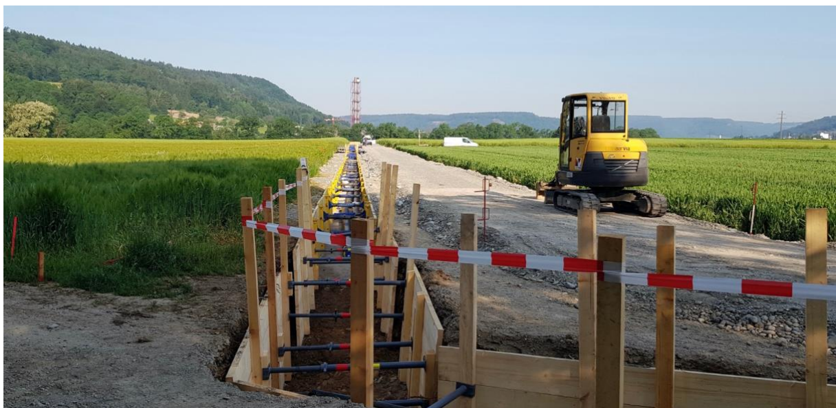
Die Fernwärme-Verbindungsleitung SIBANO führt von der KVA Turgi nach Baden, die Bauzeit betrug 14 Monate.
